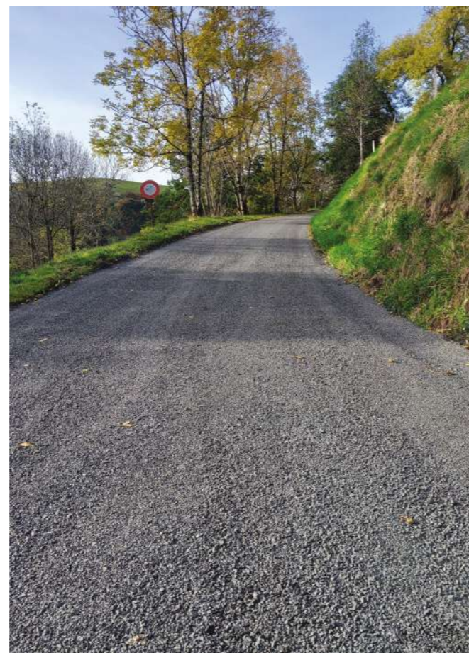
Route du Puech
